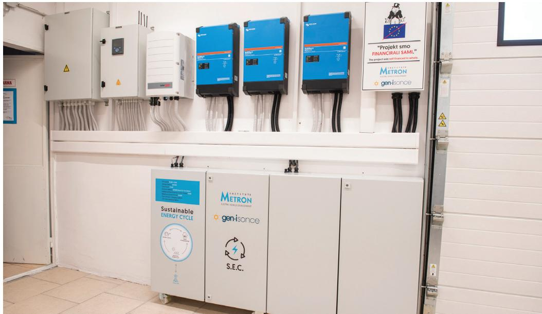
Trajnostni energetski krog (TEK) omogoča vzpostavitev možnosti shranjevanja električne energije, pridobljene iz obnovljivih virov energije, in upravljanje hranilnikov energije v mikro omrežju na način, ki zmanjšuje vplive na elektrodistribučni sistem in pokriva konice porabe električne energije.
